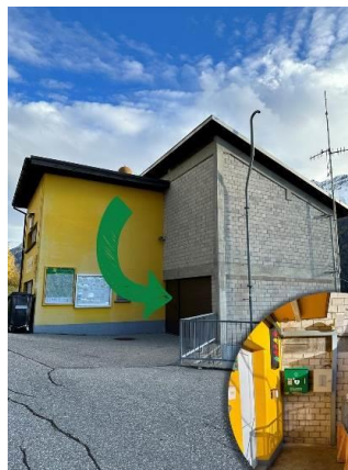
Frazione di Braggio, stazione di arrivo teleferica
