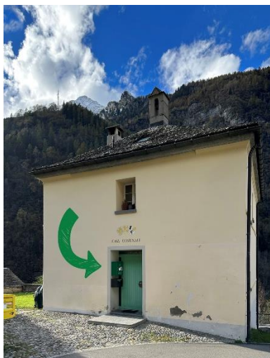
Frazione di Selma, ex casa Comunale
